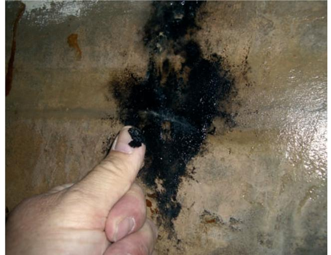
Biofilm auf Innenwand einer Wasserkammer
