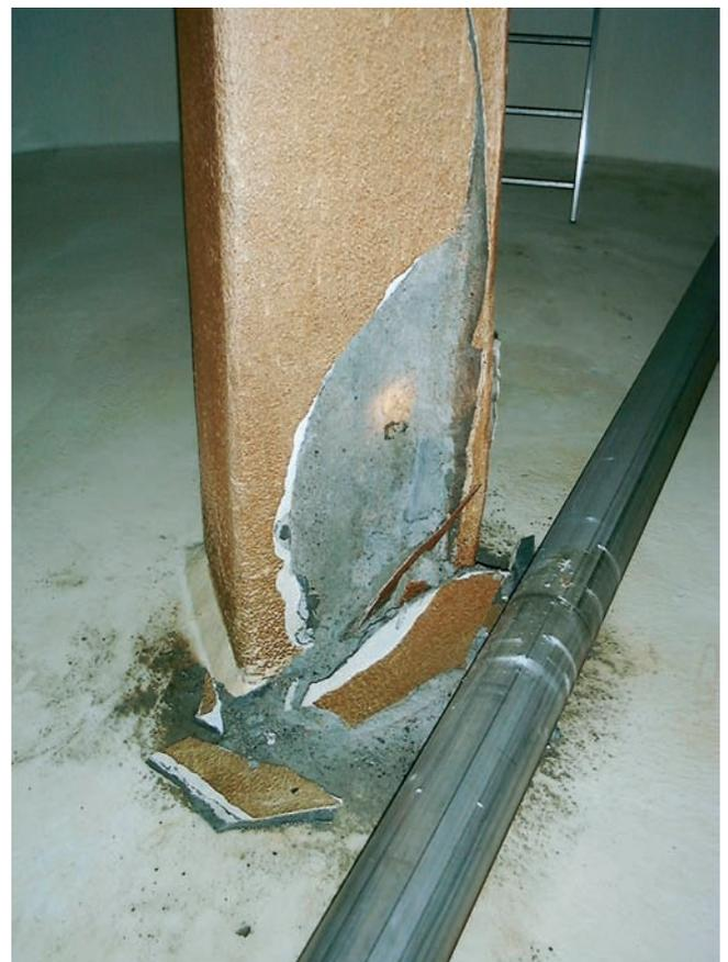
Thaumazitschaden aufgrund einer Materialverunreinigung an der Stütze in einer Wasserkammer
