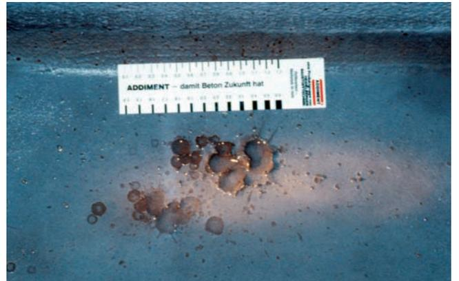
Schadstellen am Boden durch heruntertropfendes Kondensat kurz nach der Applikation
