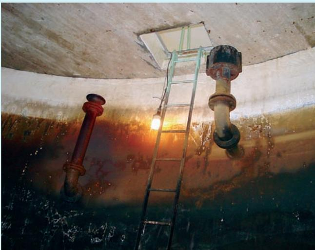
**Braune Flecken** auf einer aufgeweichten zementgebundenen Oberfläche können die Folge der hydrolytischen Korrosion sein. In den Bereichen, in denen der pH-Wert auf 8-9 abgefallen ist, kann sich sekundär ein bräunlich eingefärbter Biofilm auf der Oberfläche ausbilden. Bisher ist kein Fall bekannt, bei dem dieser Biofilm die Wasserqualität negativ beeinträchtigt hat.
