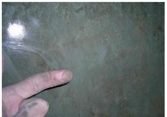
Aufgeweichte Oberfläche als labile Schutzschicht bei zementsteinangreifendem Wasser
