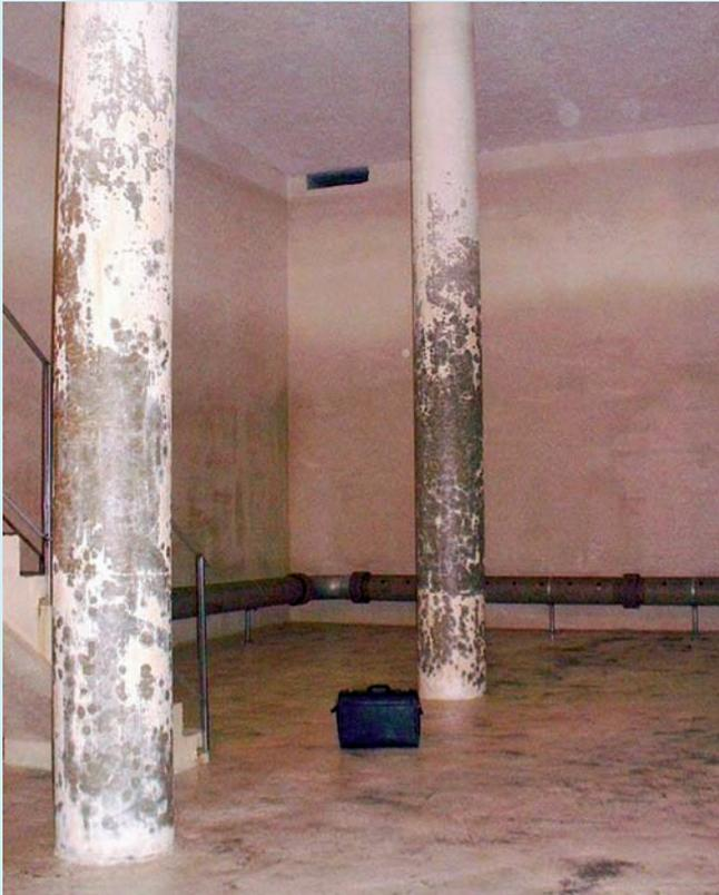
Mit dem Abbau des Zementsteins ist auch ein Verlust der hohen Alkalität des Zementsteins verbunden. Durch Anritzen der Oberfläche und Besprühen mit Phenolphthalein können diese chemisch bedingten Veränderungen im Bereich der Aufweichung optisch sichtbar gemacht werden.
