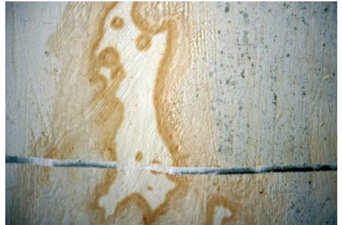
Ursachen für diese Schäden können u.a. die hydrolytische Korrosion, die Wirkung werkstoffangreifender Wässer, saurer Reinigungsmitteln und Reaktionen von Bestandteilen des Werkstoffes mit Bestandteilen des anstehenden Wassers sein.
