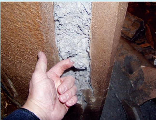
Thaumasitgeschädigter Beton in cremiger Konsistenz
