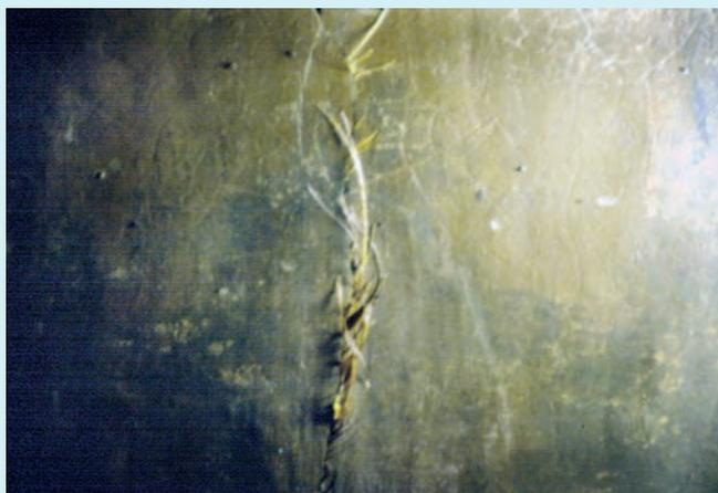
Abbildung 3: Wurzeldurchwachsung an Behälterinnenwand
