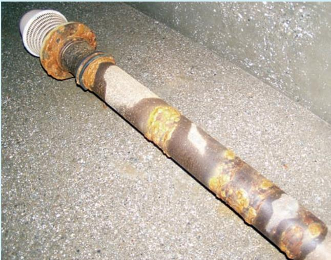
Meist endet die Schädigung der Oberfläche scharfkantig an der Wasserspiegelgrenze.
